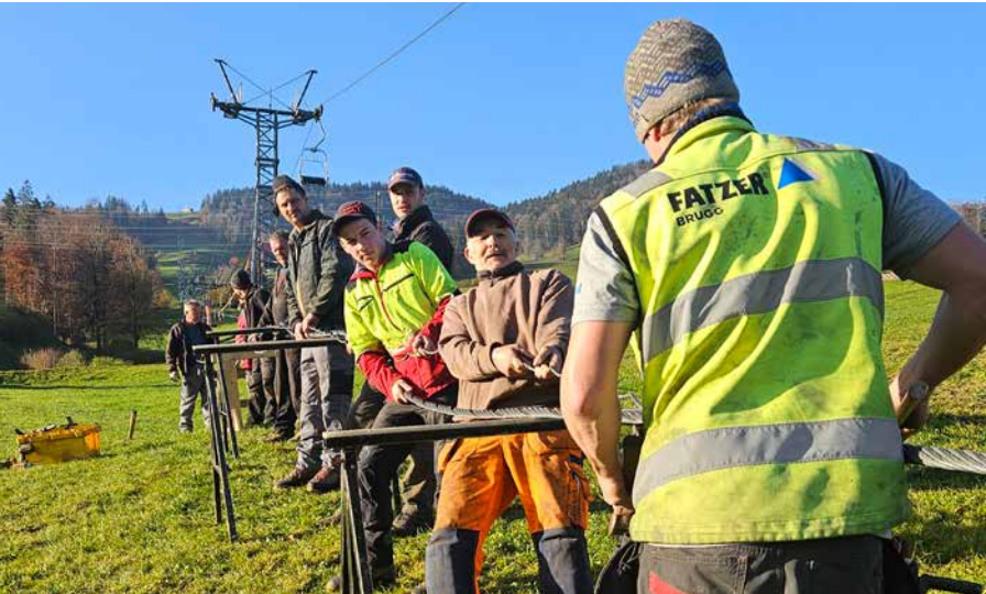
Unter Anleitung von Chefmonteur Nando Spichtig wurde das Seil im Herbst 2024 gespleisst.
