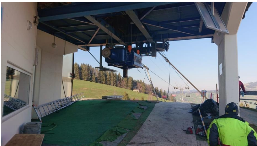
Getriebe Demontage
